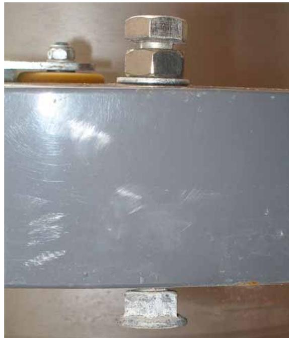
Bild 7.14 Justierschraube in Einschweißmutter am Dübelfuß innen (B)
